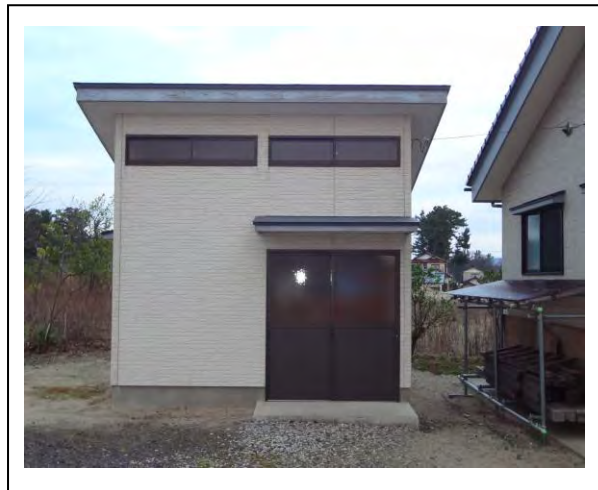
自治会館と隣接した防災資機材庫
