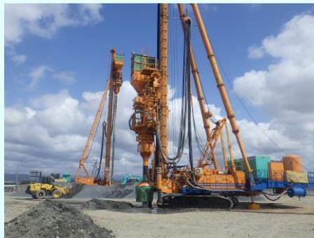
地盤改良工SAVEコンポーザー工法
