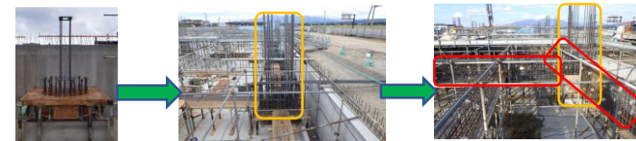
写真①:梁底型枠 写真②:柱の鉄筋 写真③:梁の鉄筋
