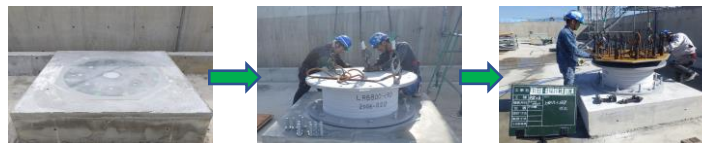
下部アンカープレート 免震ゴム取付 上部アンカープレート
