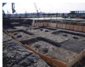
・外部への配管 ・地下の梁に管路設置
