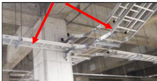
・外部への配管 ・地下の梁に管路設置
