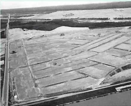
▲ 造成中の高見台
