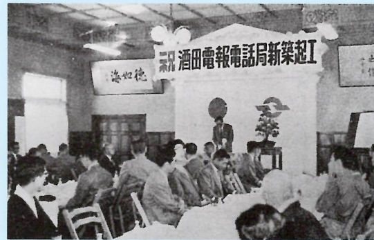
電報電話局新築起工式 (昭和44年)
