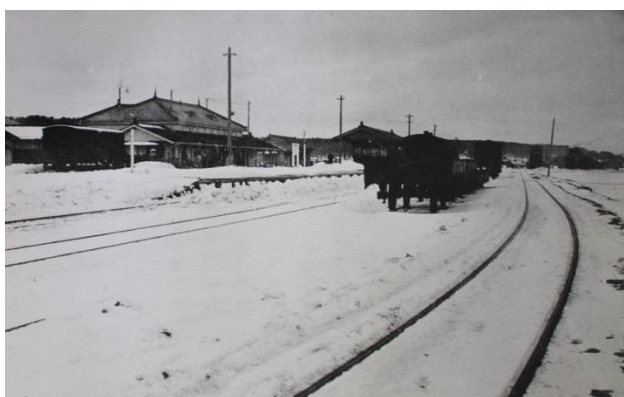
酒田駅 酒田町の東北端に作られた酒田停車場。「酒田線建設概要」には次の記載がある。 『本停車場ハ新庄起点三十四哩二十二鎖ニシテ酒田町ノ東北端ニ在リ鳥海山目睫ノ間ニ通り月山湯殿山煙波渺茫ノ裡ニ浮ヒ眺望雄大ナリ用地面積一万八千百三十八坪側線延長一哩五十六鎖餘本屋七十八面坪木造「ペイント」塗屋根ハ葺クニ石綿盤ヲ以テセリ』
