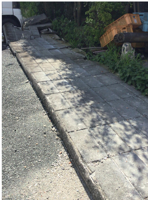
地震によりブロック塀が倒壊
