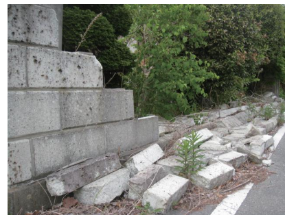
地震により石塀が倒壊
