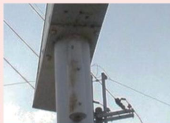
看板本体からボルトへの汚ダレ
