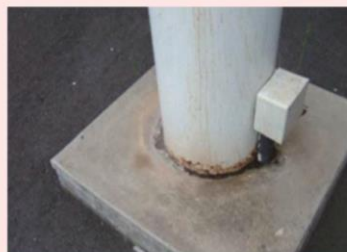
ボルトの根元にサビが発生
