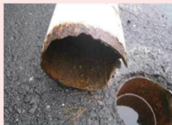
ボルトの根腐れによる倒壊
