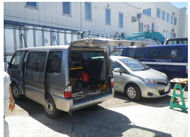
× 工事関係車両のトランクドア開けっ放し トランクドアが開けっ放しであるため、接触等の危険がある。
