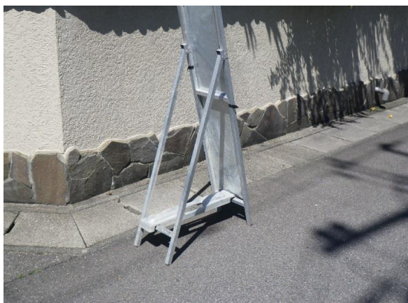
× 設置した看板に重石がない 看板に重石がないために、風等で転倒する可能性がある。
