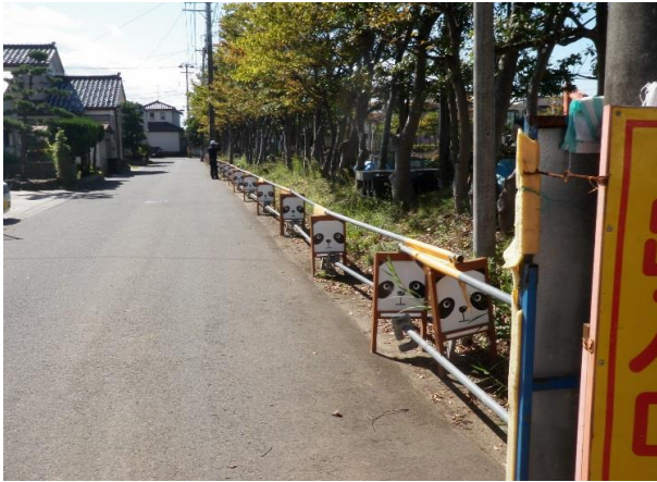
○子供へ配慮したガードパイプの設置 小学校の現場であることに配慮した、親しみあるガードパイプを設置している。
