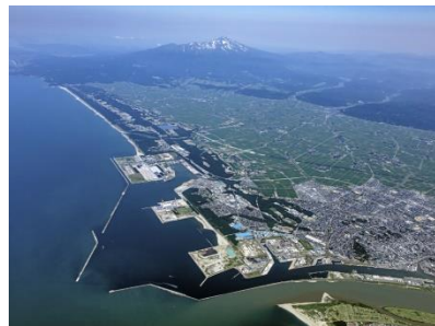
写真提供：国土交通省東北地方整備局 酒田港湾事務所（平成 29 年撮影）
