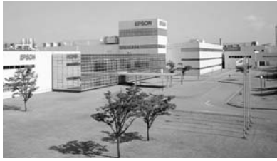
本社工場の外観
