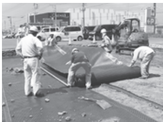
ジオ・ダブルサンド工法の施工
