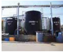
水処理用の凝集剤など液体の化学薬品を種類ごとに貯蔵しています。
