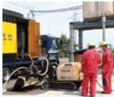
ロボットとポンプ車を用い、 高水圧の水でコンクリート 面を削ります。
