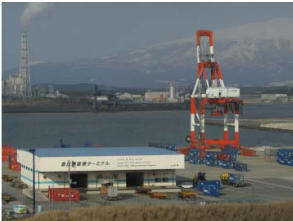
酒田港国際ターミナル (ガントリークレーン)
