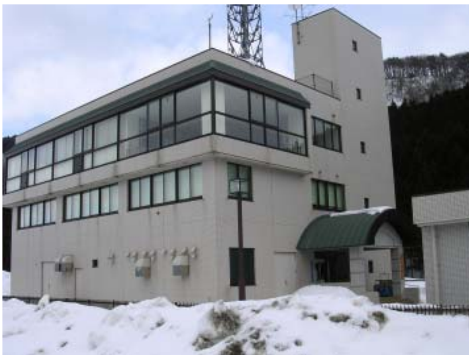
東北地方整備局酒田河川国道事務所飽海出張所
