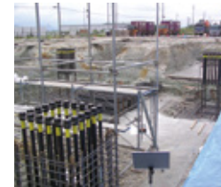
アンカーボルトと梁台がユニツト化され、基礎工事のスPEEDが格段にアップした「Dスルー工法」。当社では施工も行っています。
