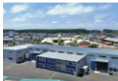
本社工場(平成27年7月竣工)
