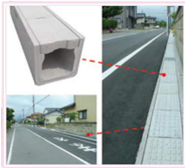
防音側溝の施工例 (市内東泉町地内の市道)
