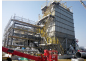
大型集塵装置の施工風景
