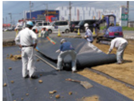
ジオ・ダブルサンド工法の施工
