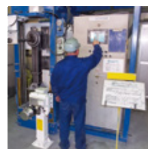
補助脚の荷重試験
