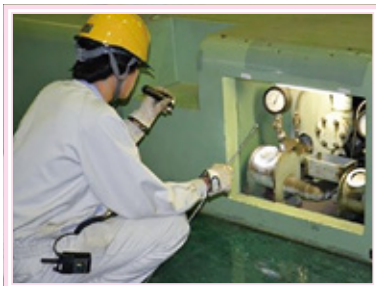
発電設備の日常巡視点検の風景
