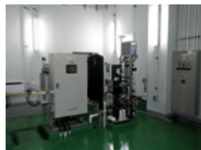
浄水処理設備
