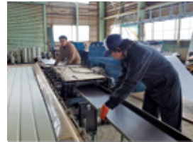
板金屋根材の加工
