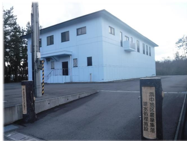
写真2-2 真空式システムの浜中地区農業集落排水処理施設
