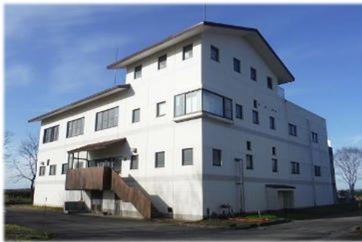
写真2-1 八幡浄化センター
