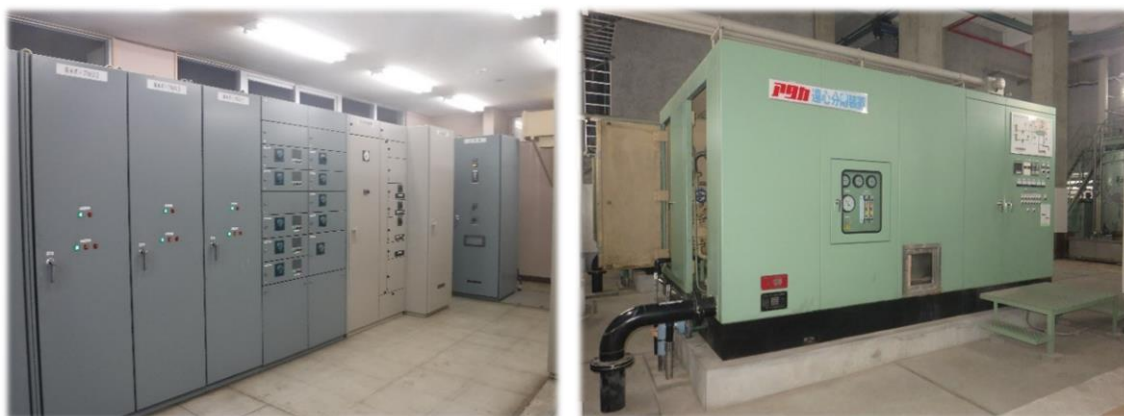
写真4-3 改築予定施設及び設備
