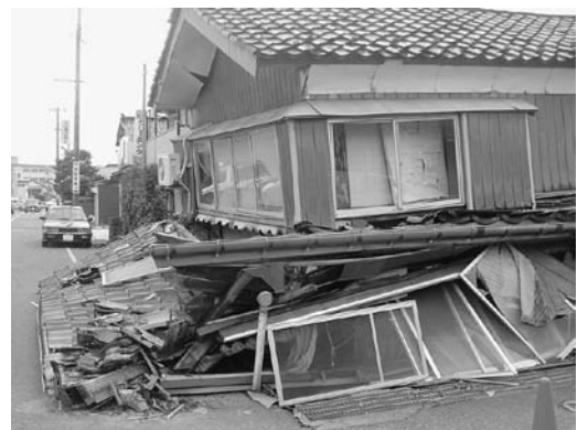
▲新潟県中越沖地震(平成19年)で倒壊した住宅
