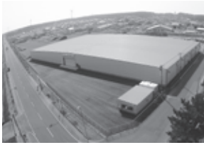
北浜倉庫(平成27年5月竣工)
