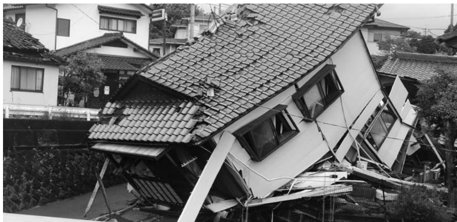
▲熊本地震で倒壊した家屋（益城町）
