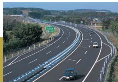
日本海沿岸東北自動車道
