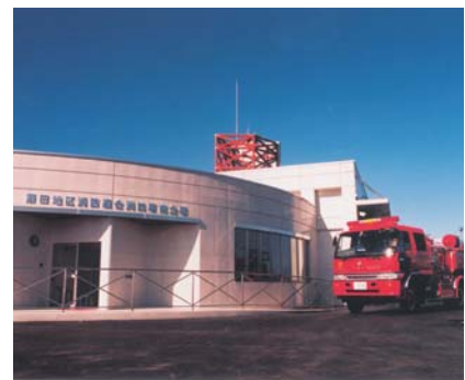
防災の拠点（南分署）
