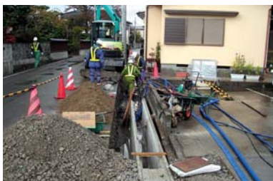
道路側溝の整備
