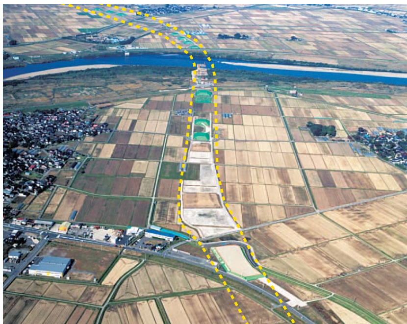
整備が進む余目酒田道路
