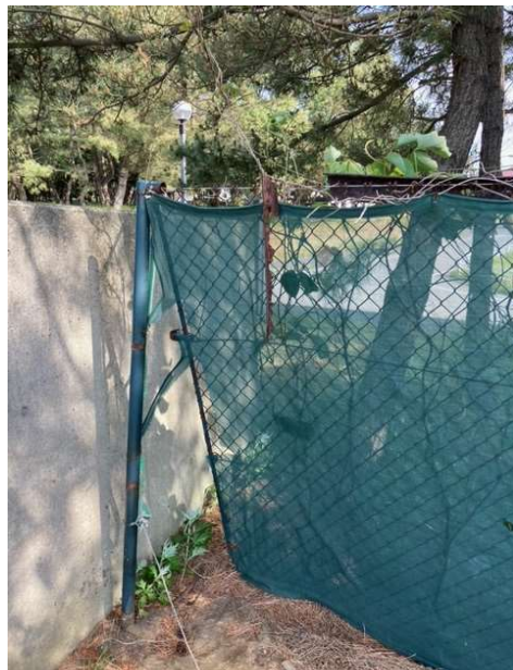
ネット取付位置の破損
