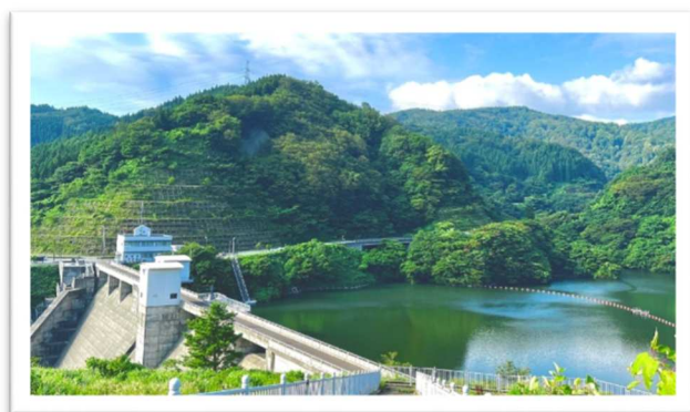
市民の水がめ「田沢川ダム」
