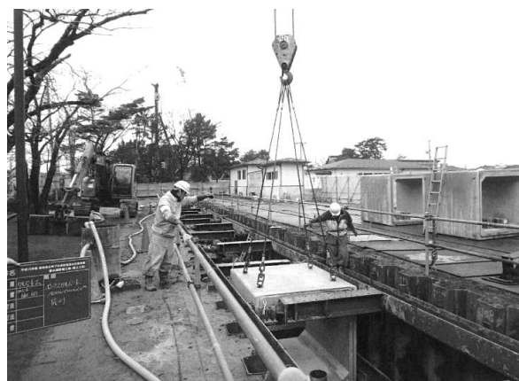
浜田地区の浸水対策工事
