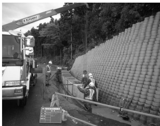
市道改良により安全な交通を確保
