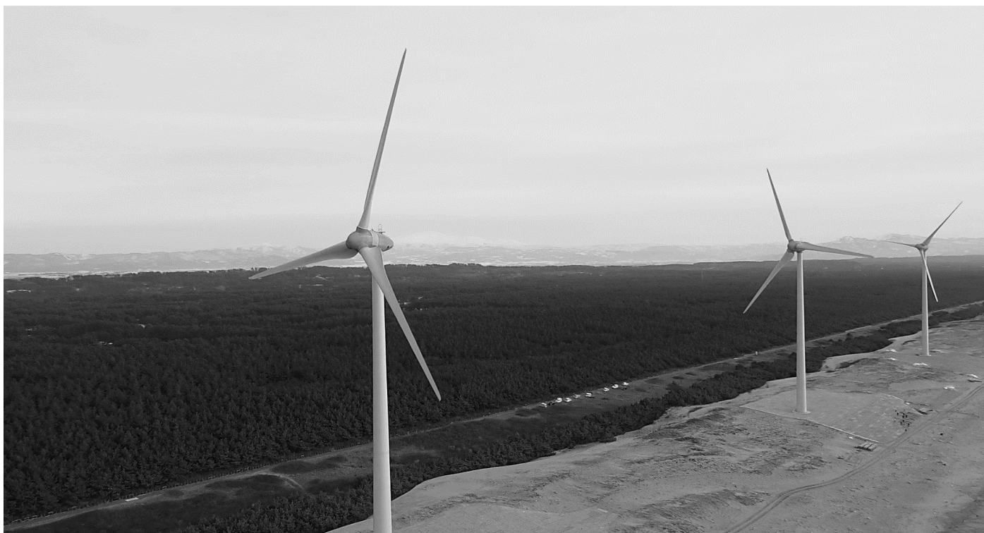
令和3年4月1日に供用開始した酒田市十里塚風力発電所
