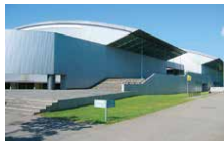
長寿命化に向けた調査を行う国体記念体育館
