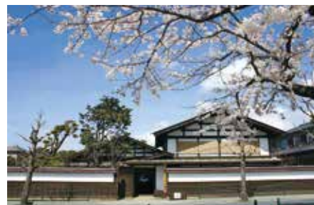
石置杉皮葺（いしおきすぎかわぶき）屋根の大規模修繕等を行う旧鑑屋
