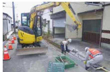
整備する側溝にはすべて蓋を設置し、道路の幅員を有効に活用します
