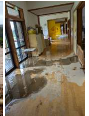
八幡保育園内部
