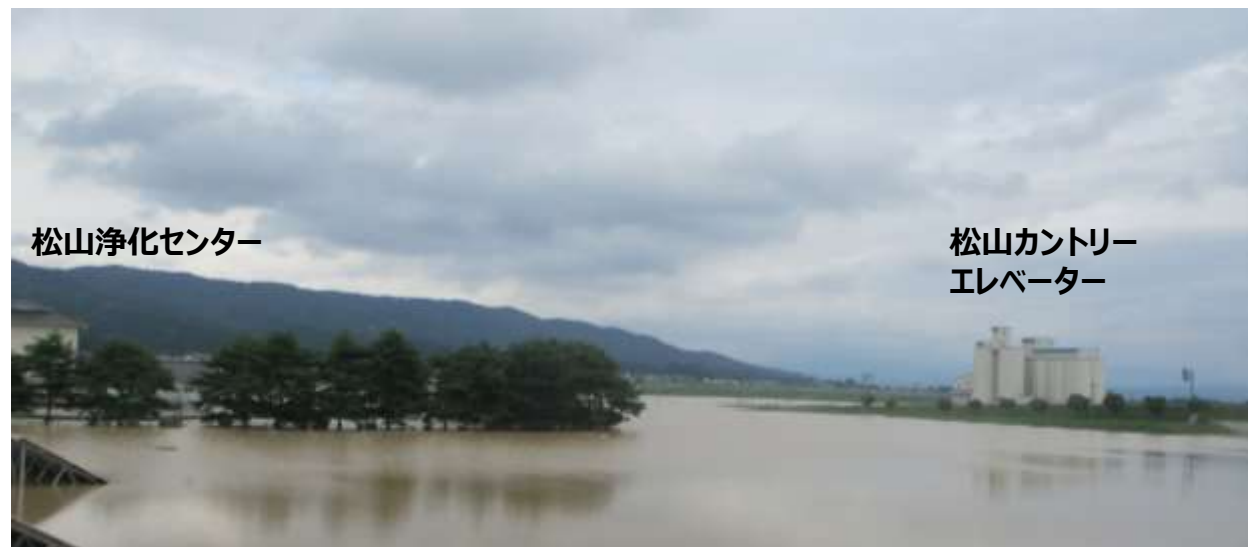
松山浄化センター～松山カントリーエレベーター周辺の浸水状況
