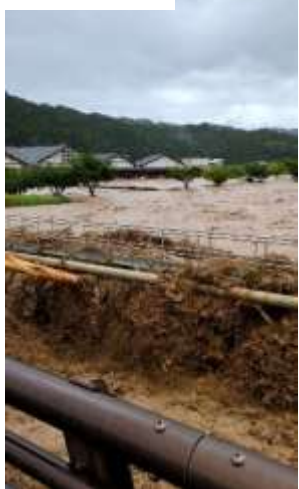
荒瀬川増水状況（7月25日撮影）
