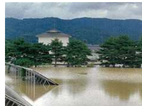
②松山浄化センター浸水状況（西側より望む）
