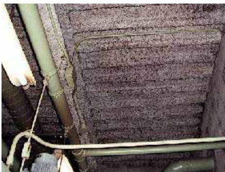
石綿含有吹付けロックウール
