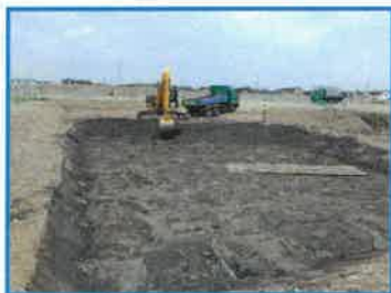
二層目掘削状況
