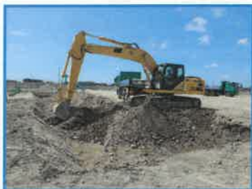
一層目掘削状況
