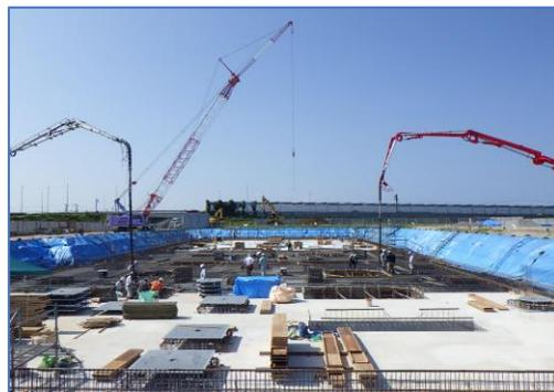
庁舎棟の基礎コンクリートは、8月31日に延べ2618㎡の打設が完了しました。
