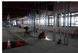
軽量鉄骨取付状況
