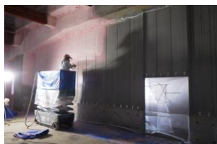
ウレタン吹付状況
