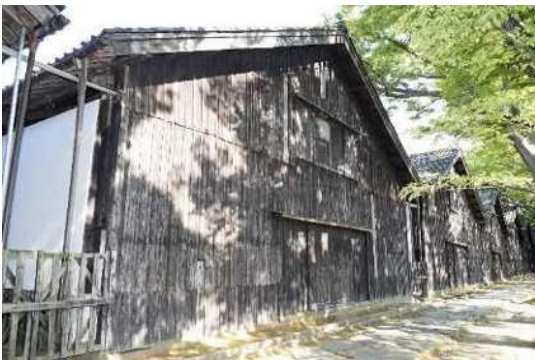
写真 5-3-3 外壁下見板
