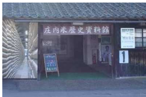
写真 5-4-3 1号棟下屋と同一の外部通路の舗装レベル
