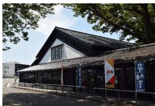
写真 5-4-2 12号棟屋外スロープ
