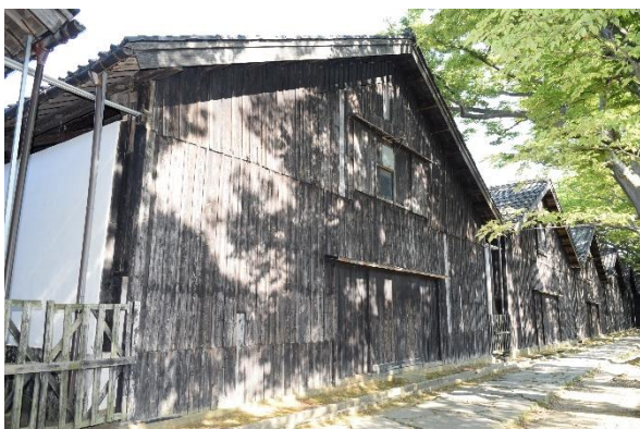
写真 5-2-3 外壁下見板
