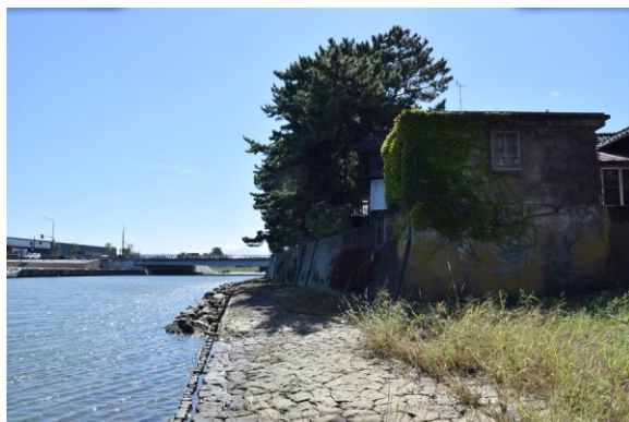
写真 5-2-7 新井田川護岸根固めの 石敷と松杭
