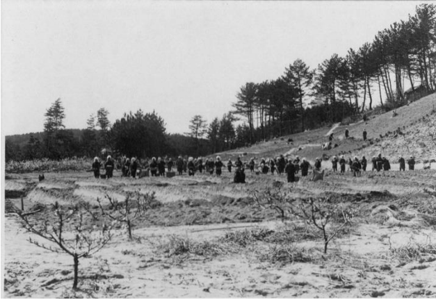
赤川新川掘削工事の様子
