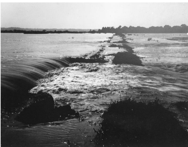
明治38年(1905)の洪水による大宮小野寺堤防の決壊
