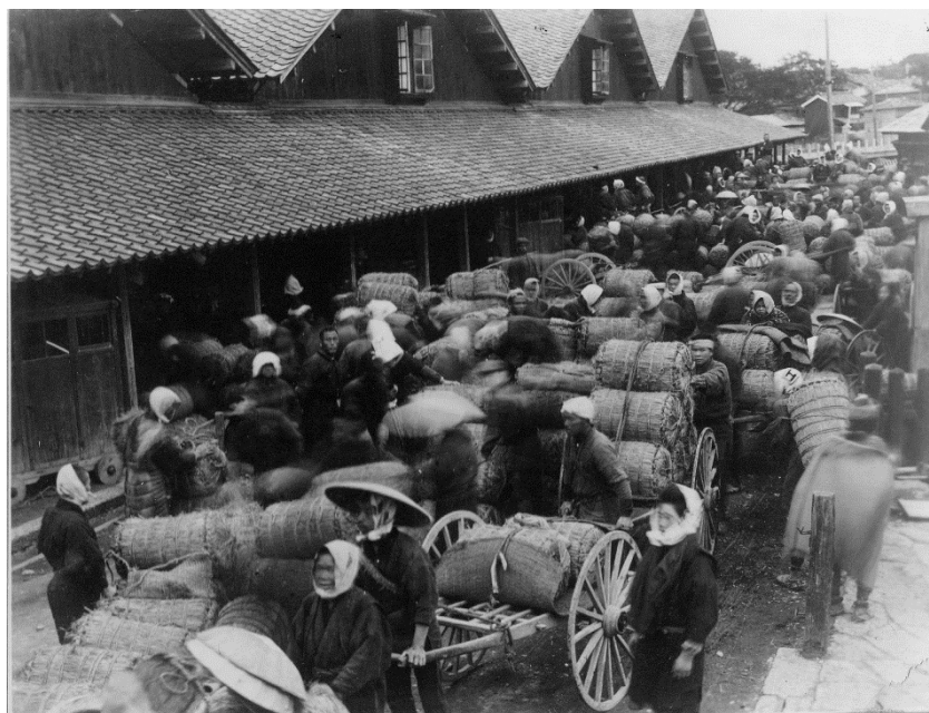
山居倉庫の入庫風景 大正14年(1925)
