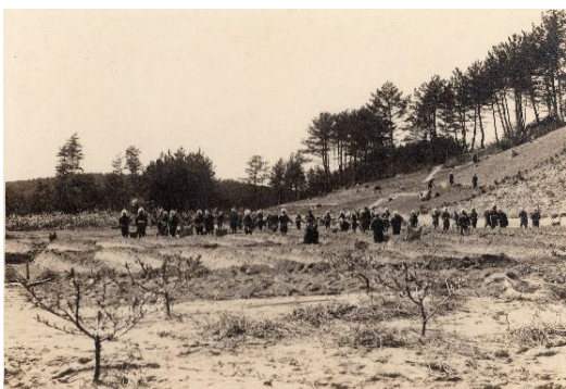
赤川新川掘削工事の様子 (大正)
