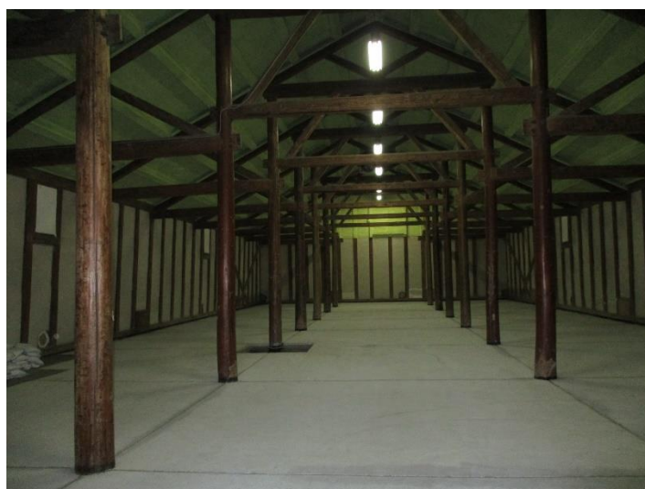
山居倉庫 10号棟入口から奥
