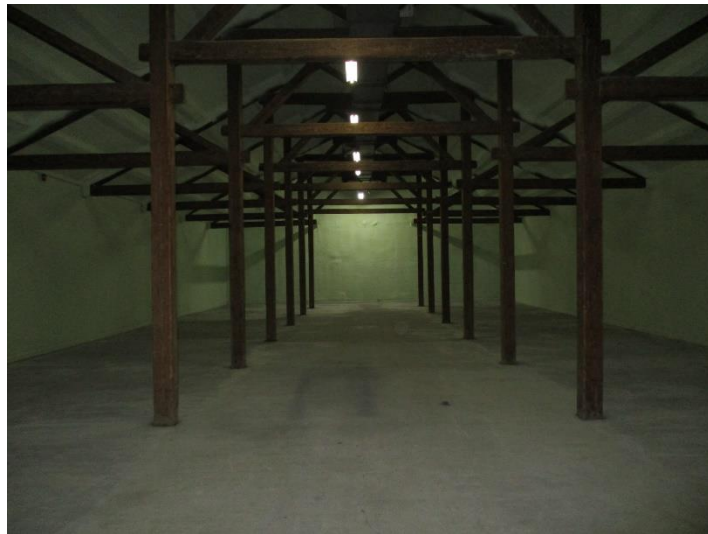
山居倉庫 6号棟入口から奥
