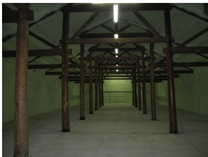
山居倉庫 8号棟入口から奥
