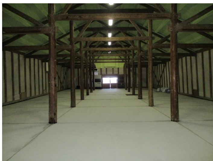
山居倉庫 10号棟奥から入口
