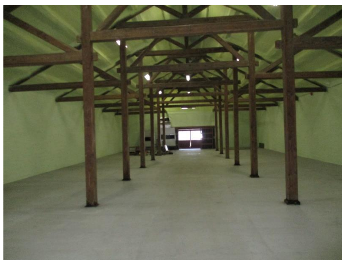
山居倉庫 7号棟奥から入口
