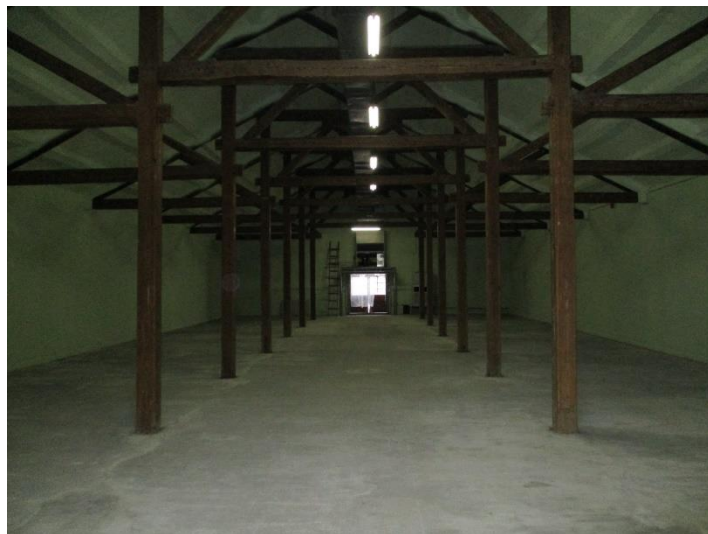
山居倉庫 6号棟奥から入口
