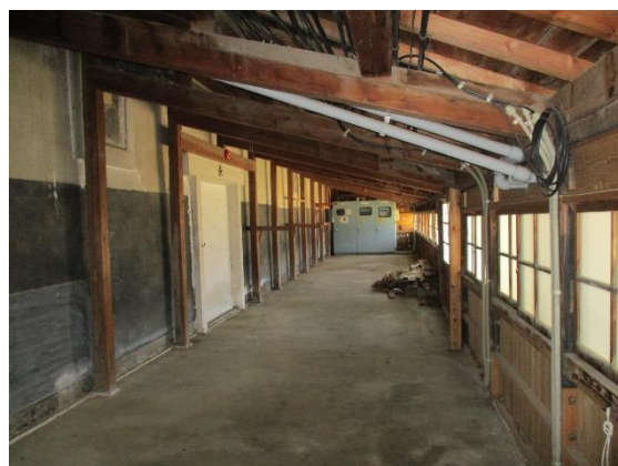
山居倉庫 6号棟下屋入口から奥
