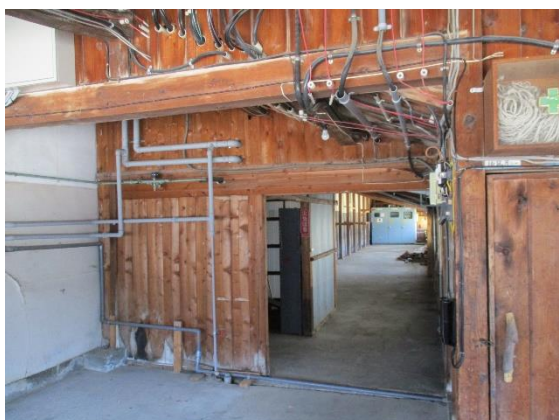
山居倉庫 6号棟下屋入口
