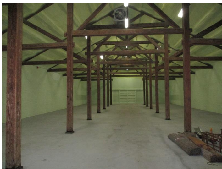
山居倉庫 7号棟入口から奥
