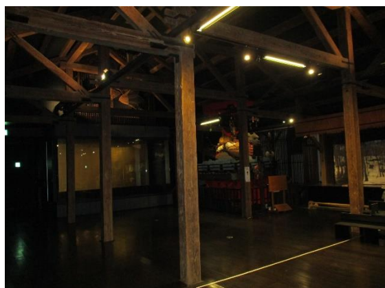
山居倉庫 11号棟内部
