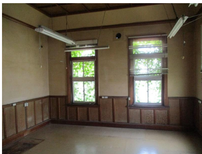
研究室棟 2階 検査室
