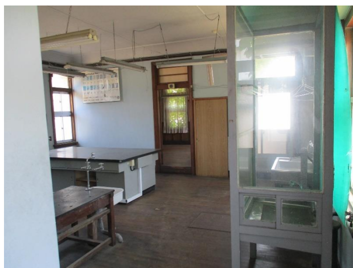
研究室棟 1階 準備室
