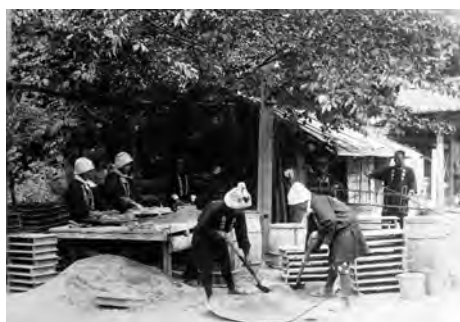
建設作業のようす / 大正14(1925)年
