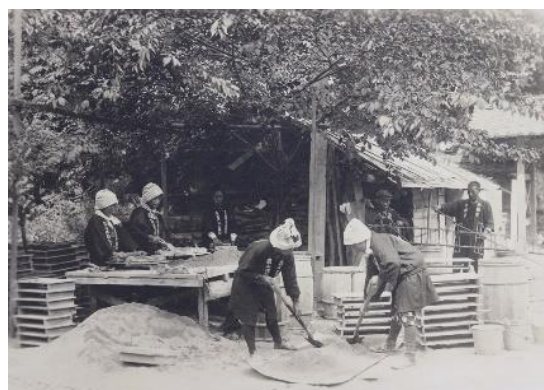
森山式鉄筋コンクリートブロック 製造作業のようす
