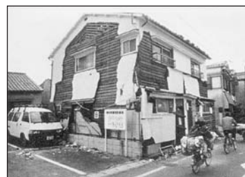
地震によるモルタルの剥離
