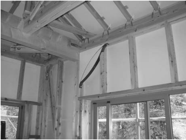
写真 -14-1 板ばね型仕口ダンパー
