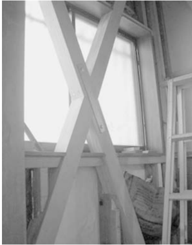
筋かい補強の例
