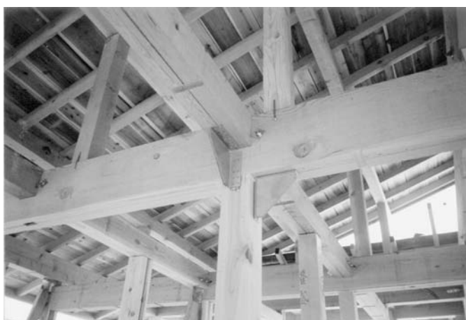
写真 -13 鋼板型仕口ダンパー
