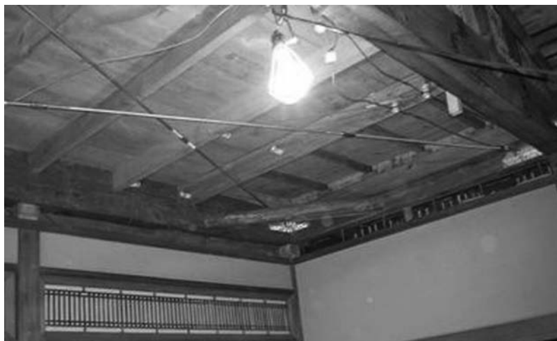
写真-12 床補強工法
