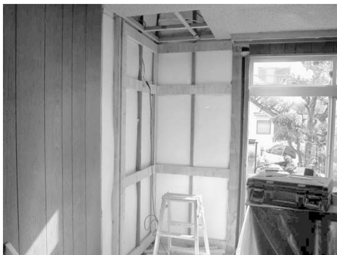
写真 -10-2 かべ大将（下地施工）
