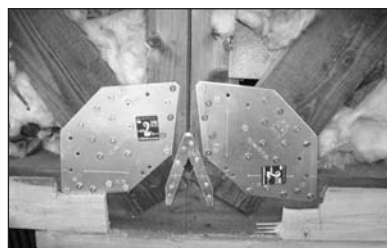
筋かいの金物補強例
