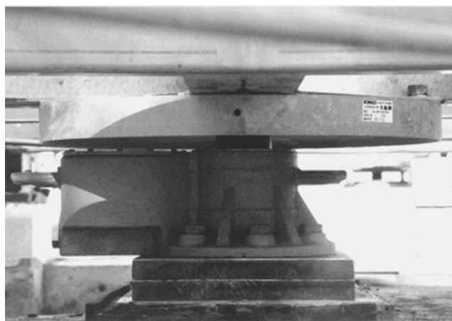
写真 -16-2 全方位対応型オイルダンパー
