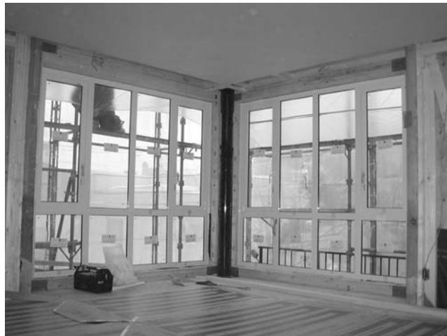
写真 -18-2 開口部補強例(2)
