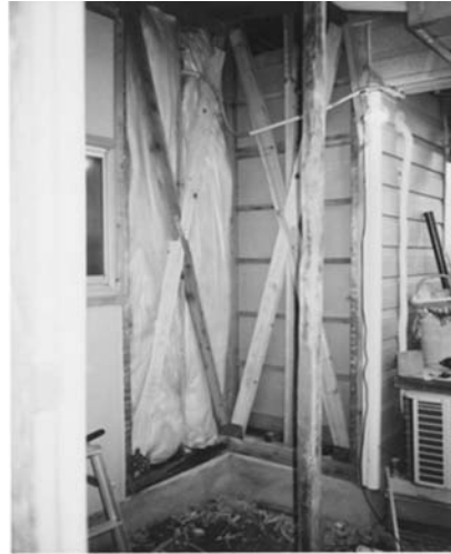
筋かい補強の例
