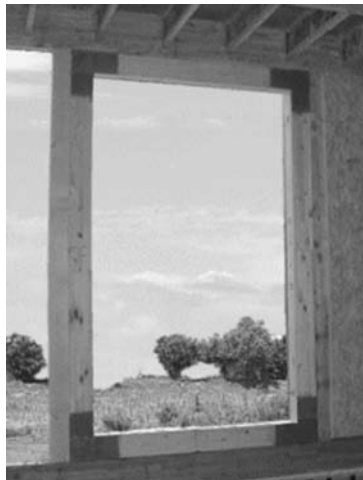
写真 -18-1 開口部補強例(1)
