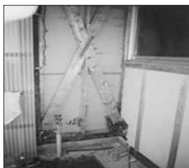
部分的な耐震補強例
