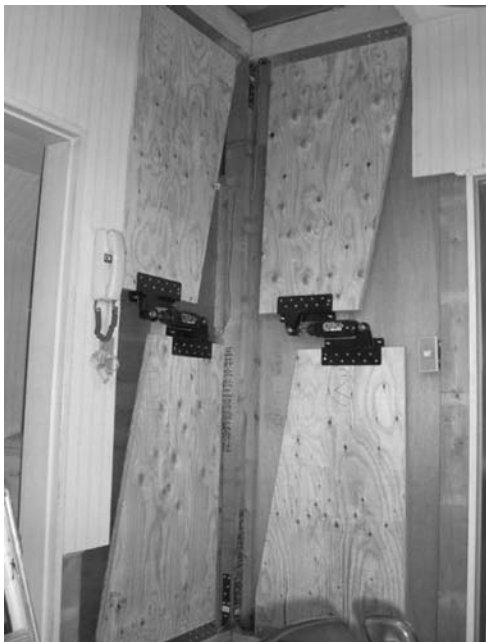
写真 -15-1 オイルダンパー取り付け
