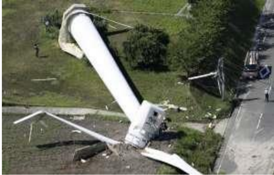
タワーの転倒(2018淡路島)
