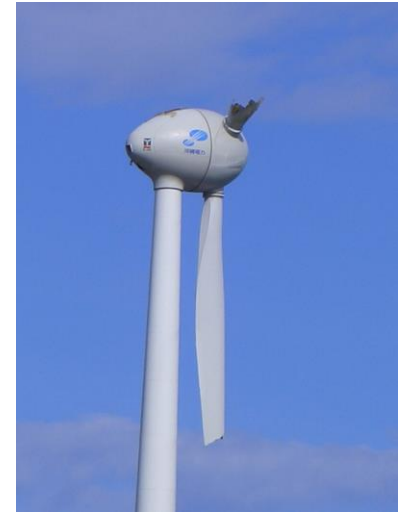
ブレードの破損
