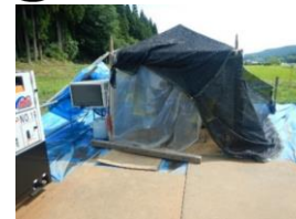
現場休憩所へのスポットクーラー設置
