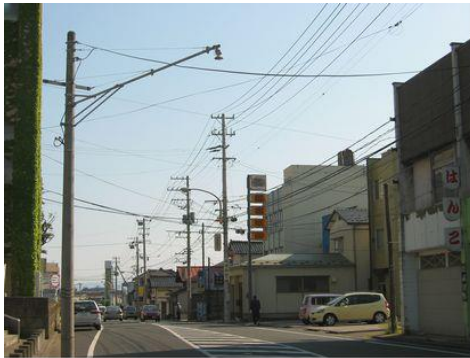
林立する電柱、電線が頭上を縦横に走る(本町)
