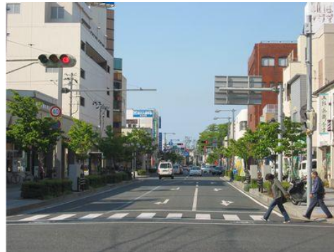
無電柱化により、すっきりとしたまちなみ(中町)
